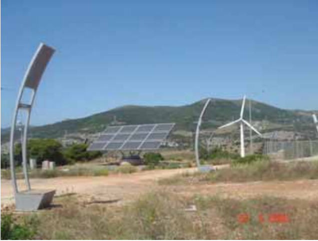
Πάρκο ανανεώσιμων πηγών ενέργειας (ανάπτυξη φωτοβολταϊκών πινακιδίων και ανεμογεννητριών)
