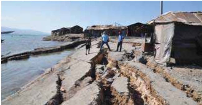
Ρευστοποίηση και πλευρικές επεκτάσεις στο λιμάνι Paurt-au-Prince της Αϊτής, οι οποίες προκλήθηκαν από τον σεισμό της 12 ης Ιανουαρίου 2010 (ερευνητική αποστολή).
