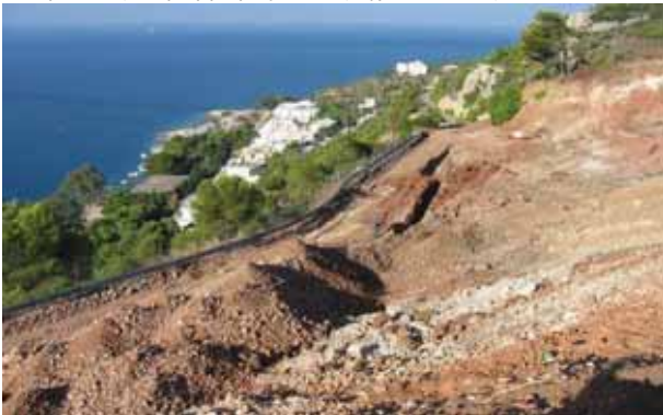
Άποψη κατολίσθησης που εκδηλώθηκε το 2006 στο πρανές ανάκτι του Δήμου Λουτρακίου (Κόρινθος).
