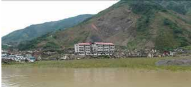
Άποψη της μέγα-κατολισθησης και της σεισμικής λίμνης που προκλήθηκαν από τον σεισμό M 8.0R, τον Μάιο του 2008 και κατάστρεψαν την πόλη Wenchuan (Κίνα).
