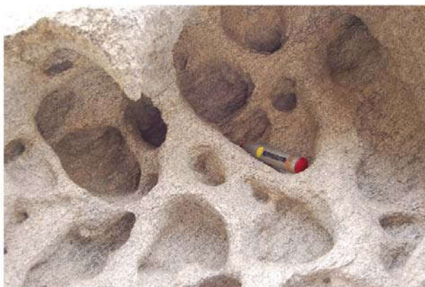
Κυψελοειδής αποσάθρωση γρανодиρίτη στην παράκτια ζώνη δυτικής Νάξου.
