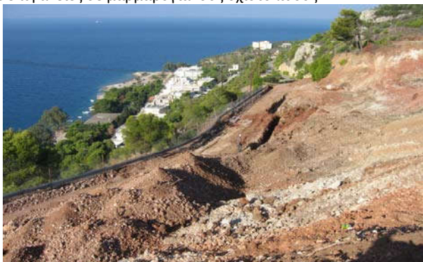
Άποψη κατολίσθησης που εκδηλώθηκε το 2006 στο πρανάς ανάτη του Δήμου Λουτρακίου (Κόρινθος).
