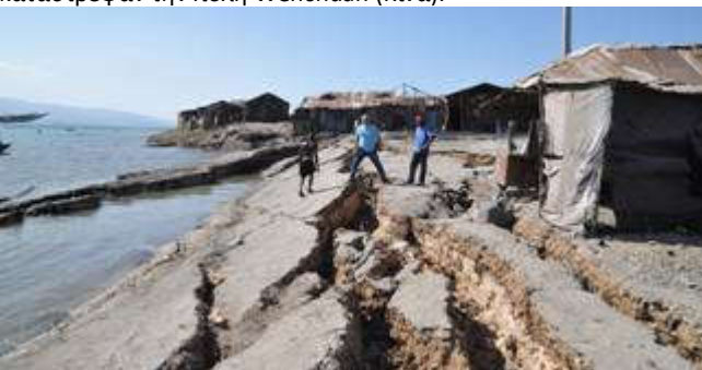
Ρευστοποίηση και πλευρικές επεκτάσεις στο λιμάνι Paurt-au-Prince της Αϊτής, οι οποίες προκλήθηκαν από τον σεισμό της 12 ης Ιανουαρίου 2010 (ερευνητική αποστολή).
