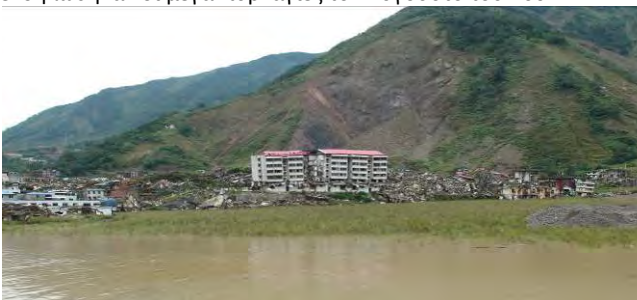
Άποψη της μέγα-κατολίσθησης και της σεισμικής λίμνης που προκλήθηκαν από τον σεισμό M 8.0R, τον Μάιο του 2008 και κατάστρεψαν την πόλη Wenchuan (Κίνα).
